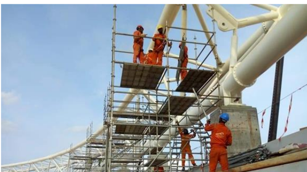
Pose de la charpente métallique au complexe sportif D'OLEMBE
