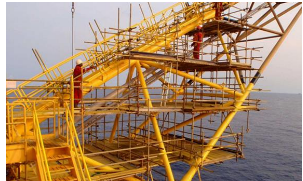
Construction échafaudage pour maintenance de la torche
