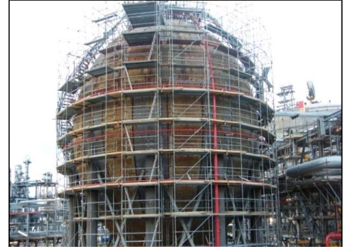
Construction de sphère au projet d'extension de la
