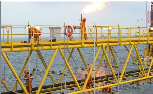
Construction de la passerelle
