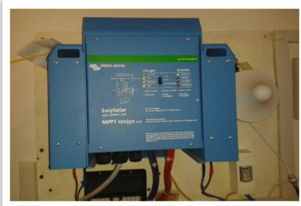
INVERSEUR VICTRON / 8 BATTERIES 200 AH
